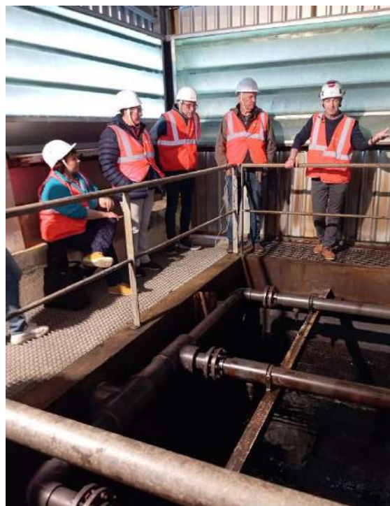
A la station d'épuration de Hères
